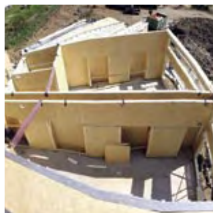
Montovaná dřevostavba z prefabrikovaných velkoplošných dílců byla postavena během osmi měsíců.
