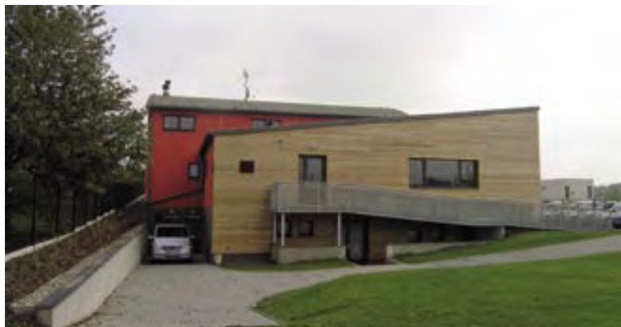
Ekologicky příznivé řešení stavby zaručuje úsporný provoz po mnoho let.
